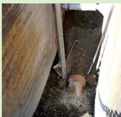
Tranchée d'une conduite d'eau potable
