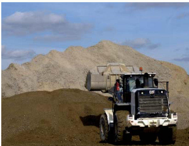
Photo 5 : Stockage des matériaux (crédit photo : YPREMA)
